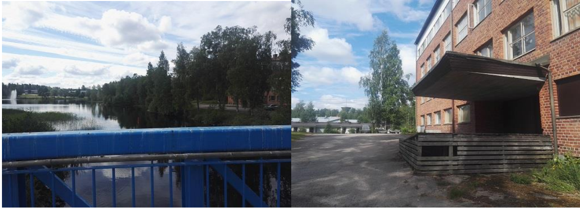
Kurkiniemen ja Kenkätehtaanniemen yhdistävä silta ja entisen kenkätehtaan rakennusta
